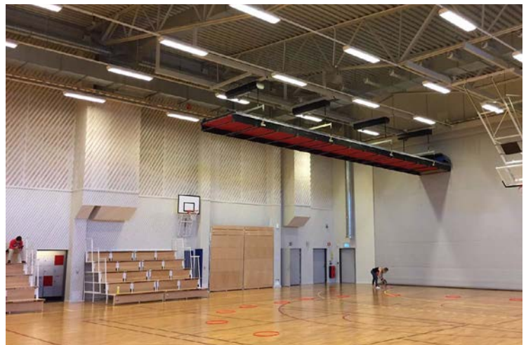
Tumblinggolv upphissat i tak och läktare nedfällbara från vägg. Foto: Unisport
